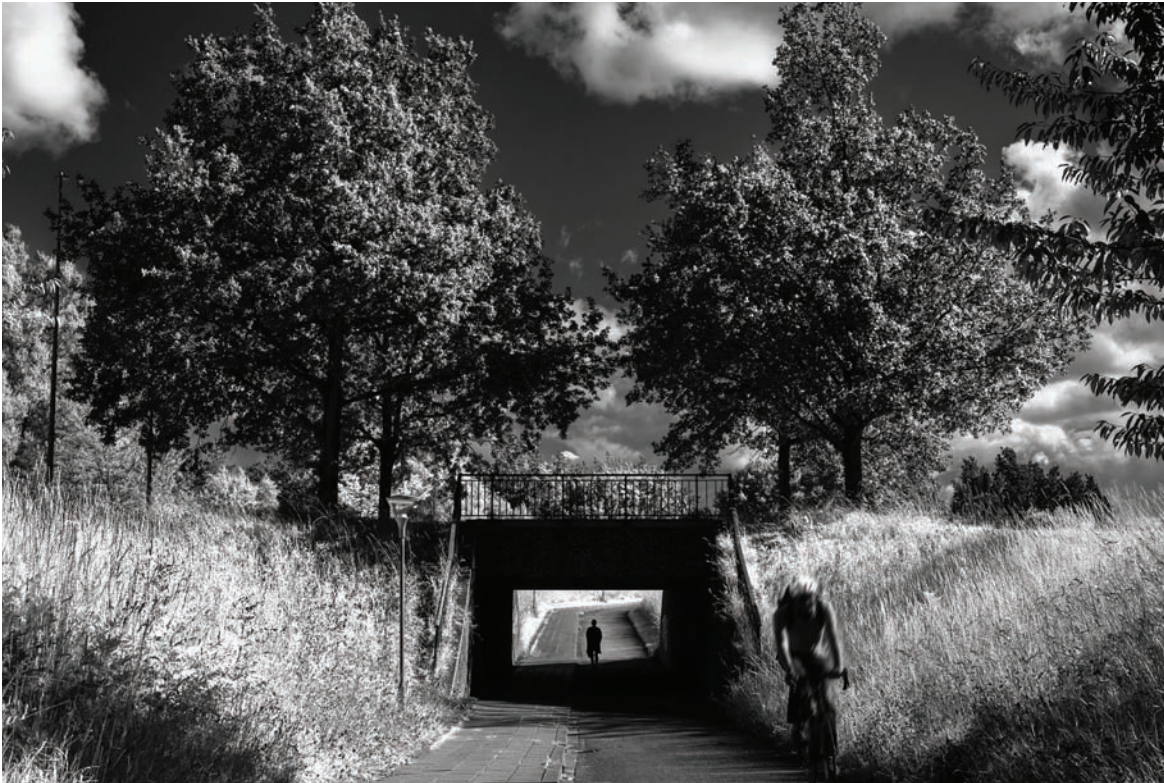
Viadukten under Klausdalsbrovej, fra Byskovvej til Gl. Klausdalsbrovej, Hjortespring, Herlev.
